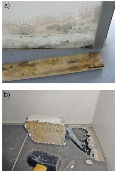
**ABB. 4 Sichtbarer Schimmel (a) ist regelmäßig mit verdeckten, nicht sichtbaren Schimmelbiotopen (b) vergesellschaftet. Vor allem in der Dämmebene von Fußbodenkonstruktionen finden sich verdeckte und zunächst nicht sichtbare Schimmelsysteme. Sie werden speziell bei versicherungsrelevanten Schimmelschäden gerne „übersehen“.**
